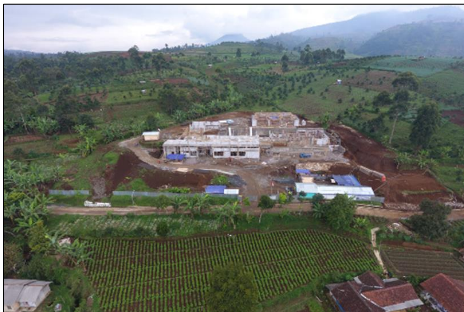
Gambar 3 Progress 35 % proyek menggunakan kamera drone
