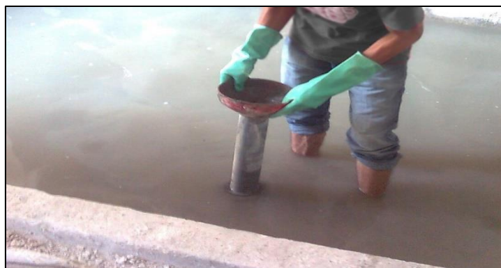
Gambar 2. Pengecoran Balok Beton Dengan Tremie Dalam Air Payau
