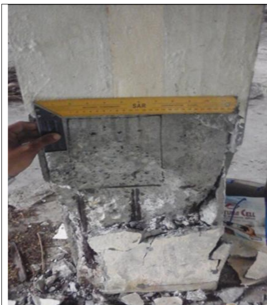
Gambar 2 : kondisi beton setelah pembobokan Sumber : Penulis
