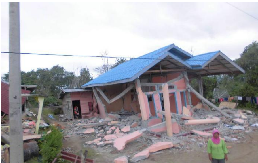
Gambar 2 Rumah Rusak Berat
