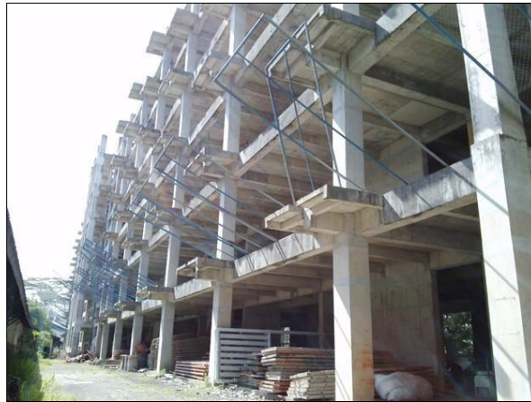
Gambar 1. Struktur gedung tujuh lantai di Barek, Sleman, Yogyakarta saat belum selesai dibangun [4]
