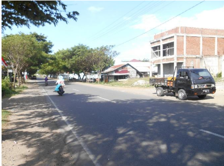
Gambar 1 Kondisi Existing Jalan Laksamana Malahayati (Km 3 – 4)
