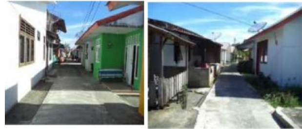
Gambar 2 Kondisi aksesibilitas jalan
