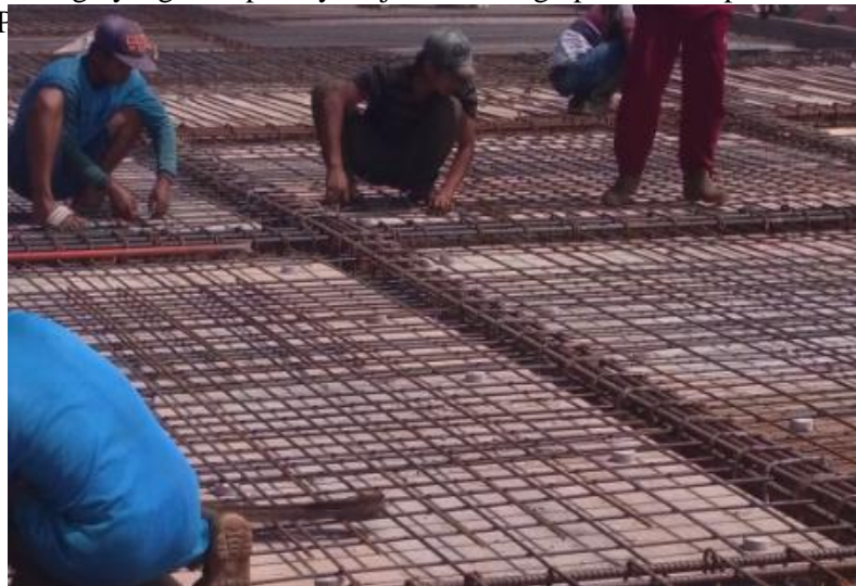
Gambar 5. Pekerjaan Balok dan Pelat
