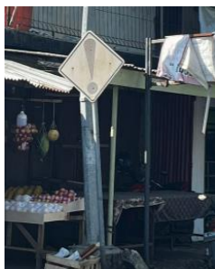
a) Kerusakan Rambu
