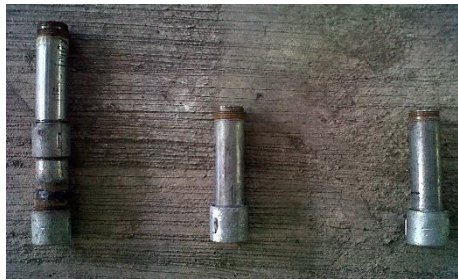
Gambar 4. Pipa Inlet pada VCT
