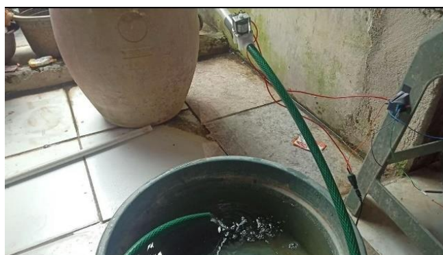
Gambar 12 Implementasi Pengujian Alat Pada Pipa Pompa Air
