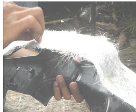
Gambar 8 Penempatan serat
