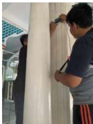
Gambar 6 Menentukan letak baja tulangan dan sengkang dalam struktur beton bertulang menggunakan profometer 5+
