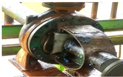
Gambar 2: Pompa Sentrifugal
