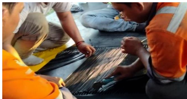
Gambar 9. Proses Penyambungan Belt Conveyor
