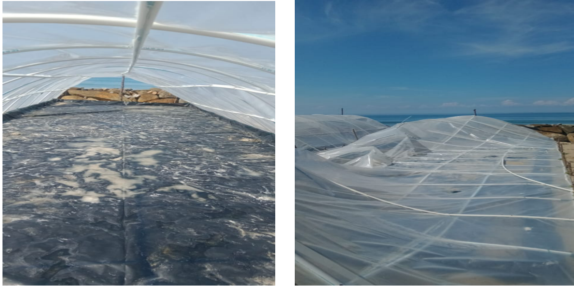
Gambar 2. Kerusakan Tunnel Garam Gampong Kuala Ba'u.
